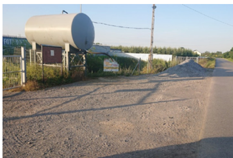
UTWARDZENIE PLACU PRZY ZBIORNIKU PRZECIWPOŻAROWYM SZKUCISKA 2 999,73 zł
