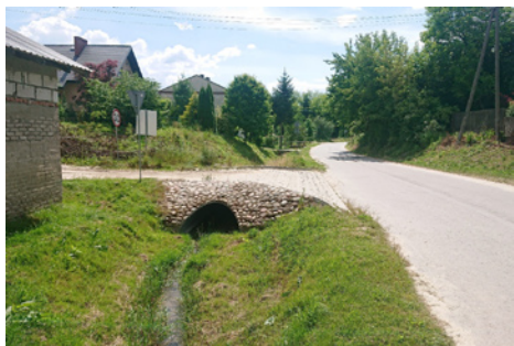
PRZEBUDOWA PRZEPUSTU W CIĄGU RZEKI JAWORZANKA ROGÓW 94 280,03 zł
