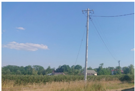
PRZEDŁUŻENIE LINII ENERGETYCZNEJ OŚWIETLENIA ULICZNEGO i ZAŁOŻENIE LAMPY KOSIORÓW 2 999,97 zł
