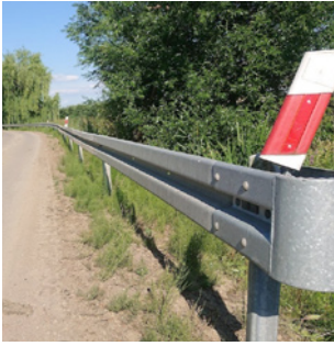
ZAKUP i MONTAŻ BARIER ENERGOCHŁONNYCH PRZY DRODZE NR108011L ZAGŁOBA 12 000,00 zł
