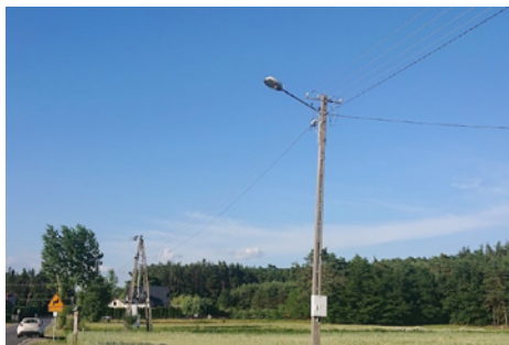
BUDOWA OŚWIETLENIA ULICZNEGO POLANÓWKA 15 160,00 zł
