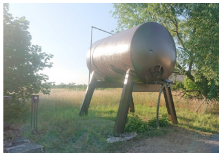
REMONT ZBIORNIKA PRZECIWOŻAROWEGO ŻMIJOWISKA
