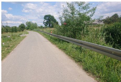
WYKONANIE BARIER ENERGOCHŁONNYCH (200 mb) ZAGŁOBA 35 670,00 zł (z funduszu sołeckiego: 20 318,00 zł)
