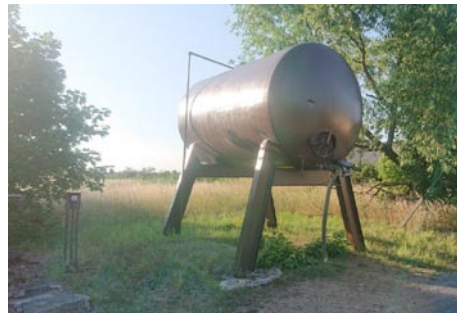
REMONT ZBIORNIKA PRZECIWPÓŻAROWEGO ŻMIJOWISKA
