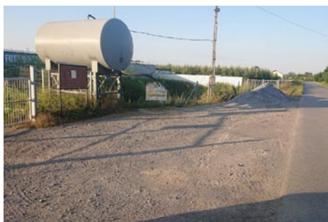
UTWARDZENIE PLACU PRZY ZBIORNIKU PRZECIWPOŻAROWYM SZKUCISKA 2 999,73 zł
